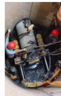
连续缠绕玻璃纤维增强塑料顶管 P17--P20
