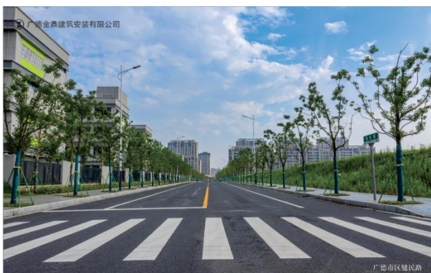
广德市健民路（苏觉路-荷花路）工程
