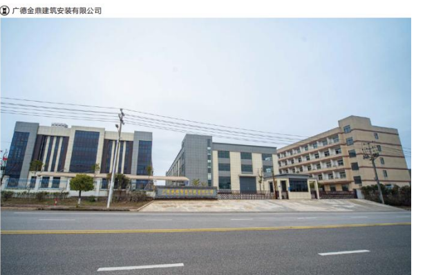
广德威铭智能科技有限公司新建厂区工程
